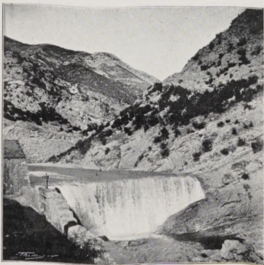
Presa del Canal de Berga
