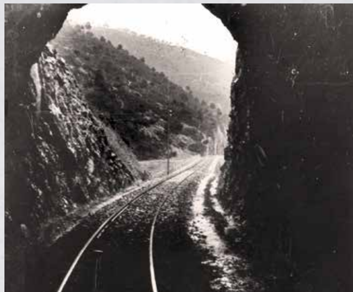
Túnel del Collet.
